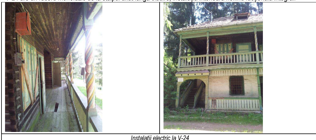
Instalații electric la V-24
