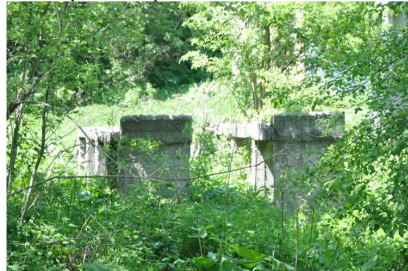
- rampă de reparare autovehicule - beton (M-20),
