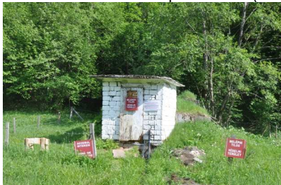
- casa de rezervoare captare 54mc (M-11),
